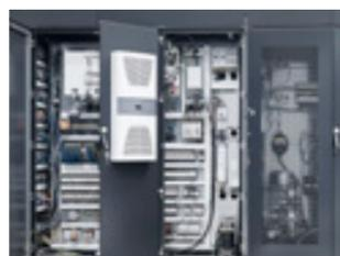
Armario eléctrico climatizado de fácil acceso.
